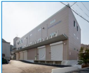
コムテックロジセンター
