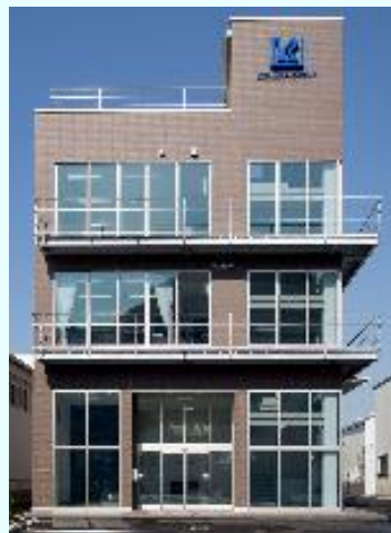
コムテックセンタービル (事務所は2Fになります)
